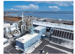
木質バイオマス発電所 新宮発電所
