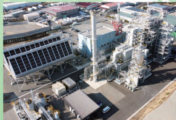
エフオングループの発電所
