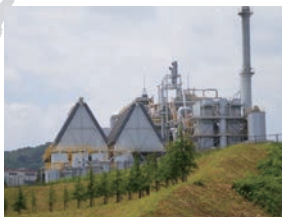
木質バイオマス発電所 大信発電所
