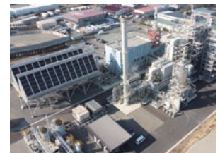
木質バイオマス発電所 壬生発電所
